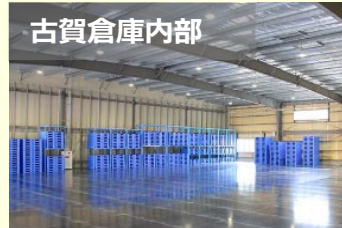
古賀倉庫内部 商品に衝撃や傷を与えないために床面に養生用鉄板を敷設
