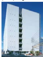
【本社工場 LD生産棟】
