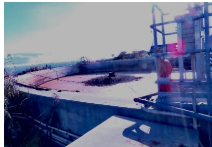
図5 消化液処理施設
