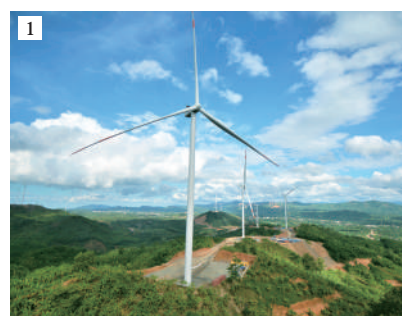
(独)国際協力機構/クアンチ省陸上風力発電事業/風力発電所 /ベトナム社会主義共和国クアンチ省(株式会社レバ提供)
