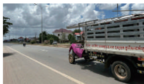
(国道5号線改修事業)
