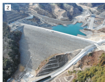
(独)水資源機構/思川開発事業/ 南摩ダム本体/栃木県鹿沼市
