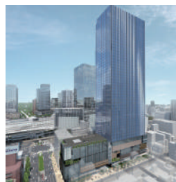
東京駅前八重洲一丁目東B地区第一種市街地再開発事業(東京都中央区)
