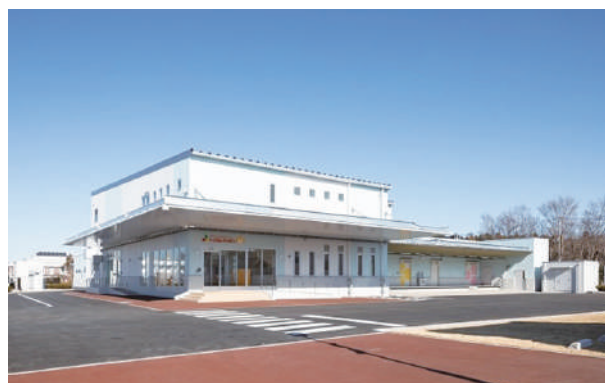
埼玉県所沢市/学校教育施設等整備事業【学校給食センター再整備事業】/ 所沢市立第2学校給食センター(愛称:トロろんキッチン)/埼玉県所沢市
