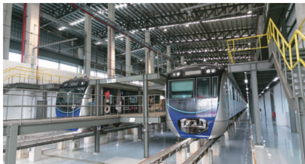
(独) 国際協力機構/ジャカルタ都市高速鉄道事業/ MRT南北線/インドネシアジャカルタ首都特別州
