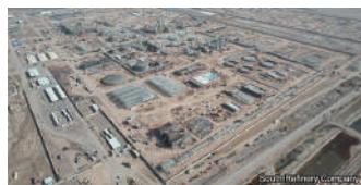
(バスラ製油所改修中の様子)
