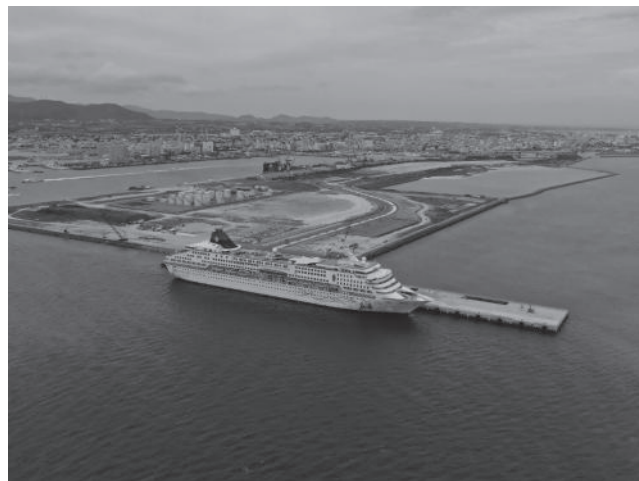
石垣港全景（提供：石垣市）
