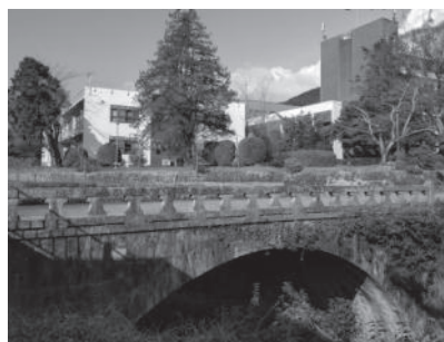
写真上は、ほぼ旧校舎の位置にある現在の校舎（経済学部本館）。1971（昭和46）年落成。手前には、「長崎高等商業学校」と刻まれた石碑が立つ。前掲写真と同方向から筆者撮影。写真下は、現在の拱橋（筆者撮影）。キャンパス内に3点ある国登録有形文化財の一つ。
