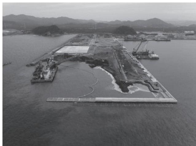
整備中の川内港唐浜地区（R8.2月撮影） 提供：鹿児島県
