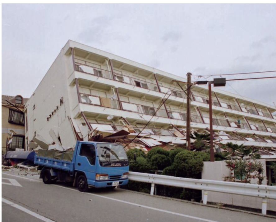
集合住宅の倒壊（平成7年兵庫県南部地震） 提供元：兵庫県西宮市
