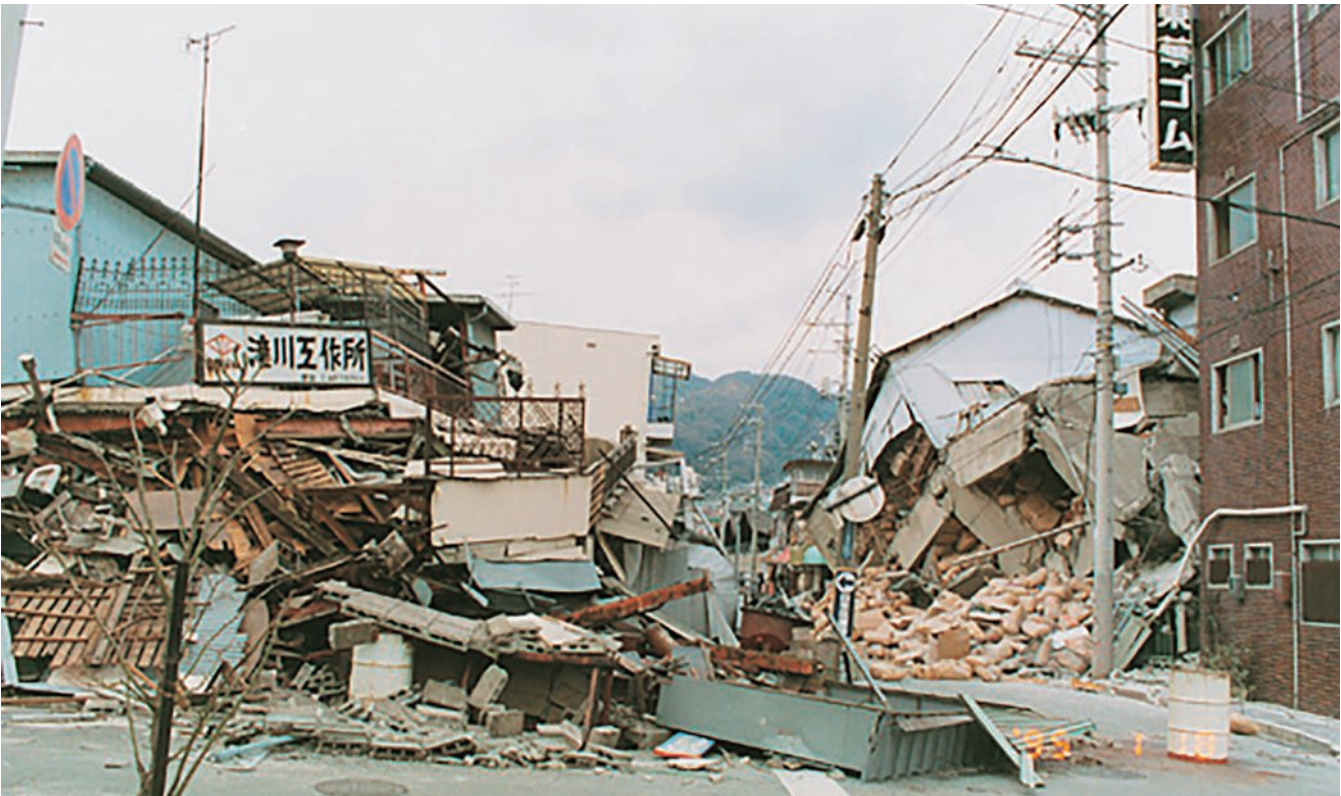
平成7年兵庫県南部地震 提供元：兵庫県神戸市
