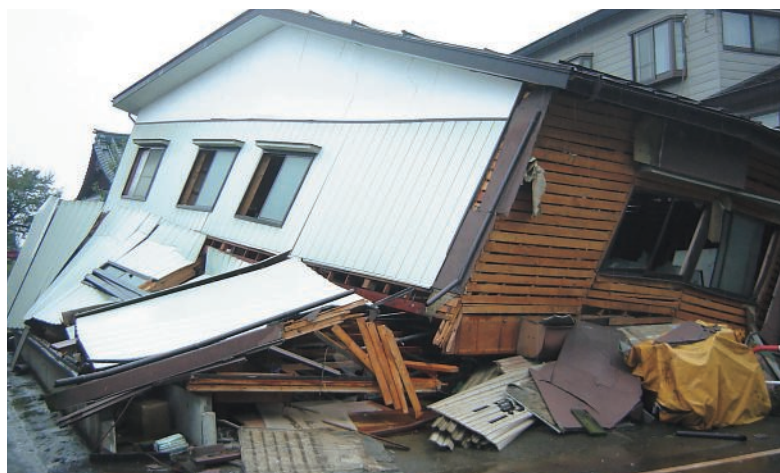
1階がつぶれてしまった住宅（平成16年新潟県中越地震） 提供元：東京都立大学 土質研究室
