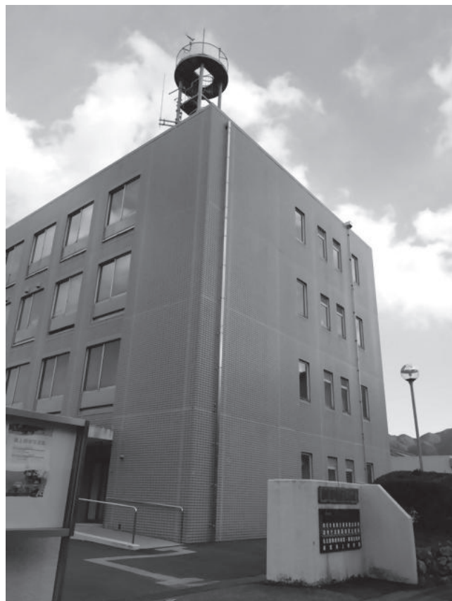
〔尾鷲地方合同庁舎〕
