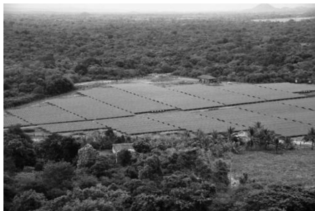
「JCM1号案件（ケビティゴレワ太陽光発電所（13.5MW）」（提供元：柴田商事株式会社）
