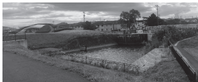
図2 石井閘門（右）と「水の洞窟」（左）（出所）令和7年10月26日・同
