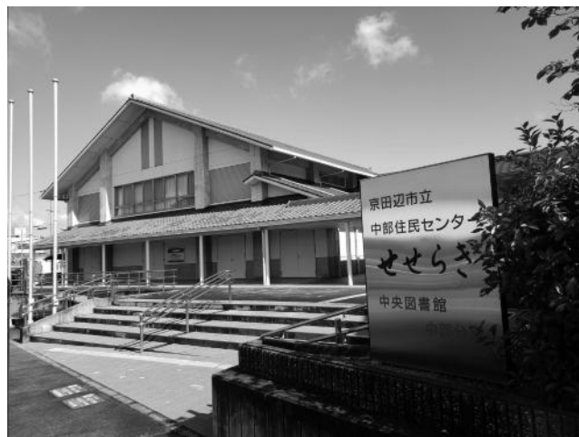
中部住民センター（写真提供：京田辺市）
