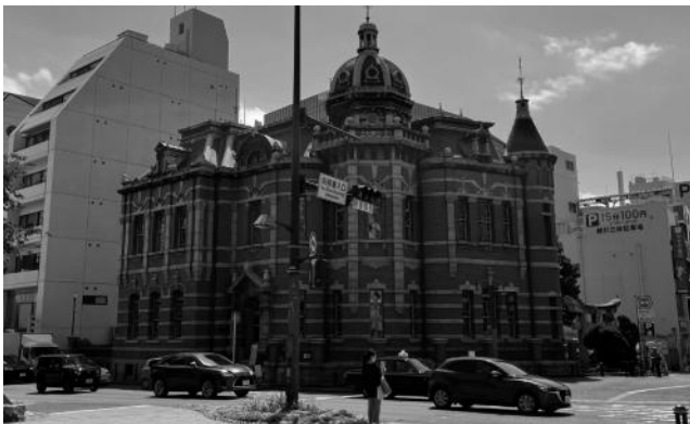
図3 中島町の福岡市赤煉瓦文化館
