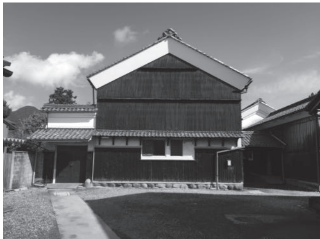
改修前の古民家
