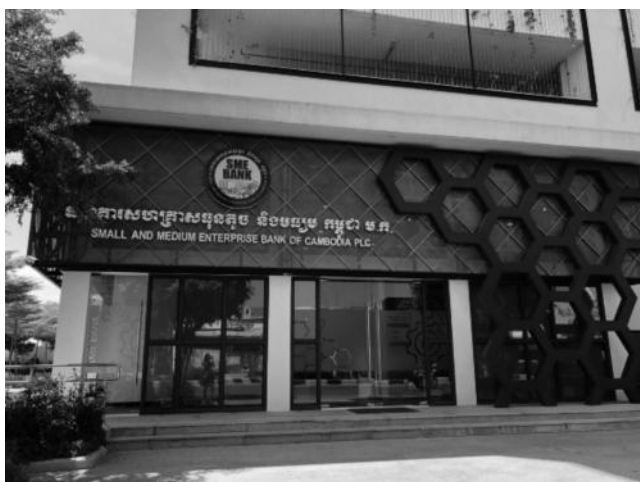
SME Bank等が入居するMEF Business Development Centerの外観
