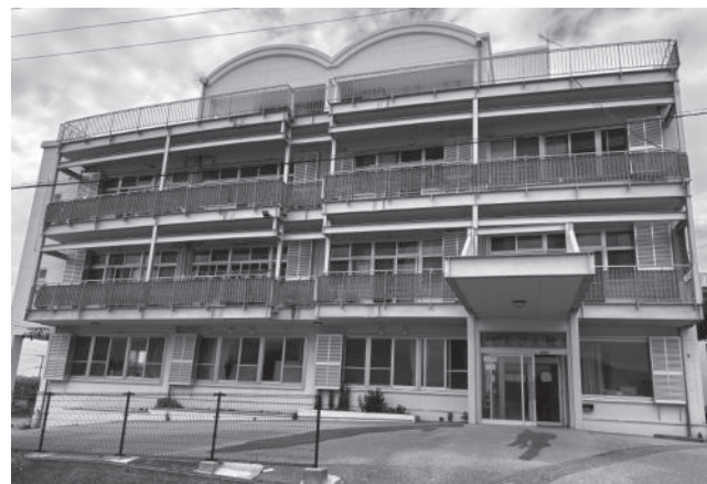
【町営寮：じんぶん館】
