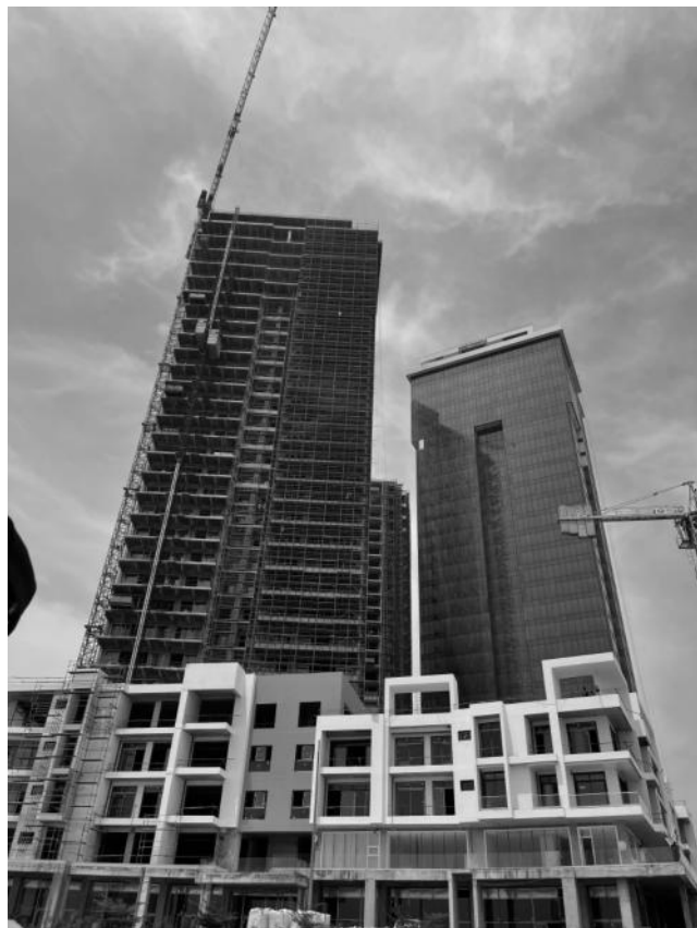
(写真1) ナイジェリアのラゴスの埋立地に建設中のタワーマンション。
