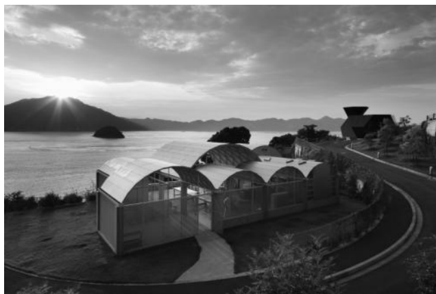
大三島のみかん畑に囲まれた傾斜地に建つ今治市伊東豊雄建築ミュージアム。手前の銀の丸屋根が建築学会賞を受賞した伊東の自邸を再現したワークショップスペース：シルバーハット、奥の黒い建物が展示スペース：スティールハット。撮影：中村絵
