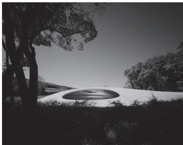
豊島美術館 広さ約40×60m、最高高さ4.3mの空間に柱が1本もなく、天井にある2箇所の開口部から、周囲の風、音、光が直接取り込まれ、一日を通して「泉」が誕生。入った瞬間、「!!!」という空間。写真：鈴木研一 Teshima Art Museum：ベネッセアートサイト直島 (benesse-artsite.jp)
