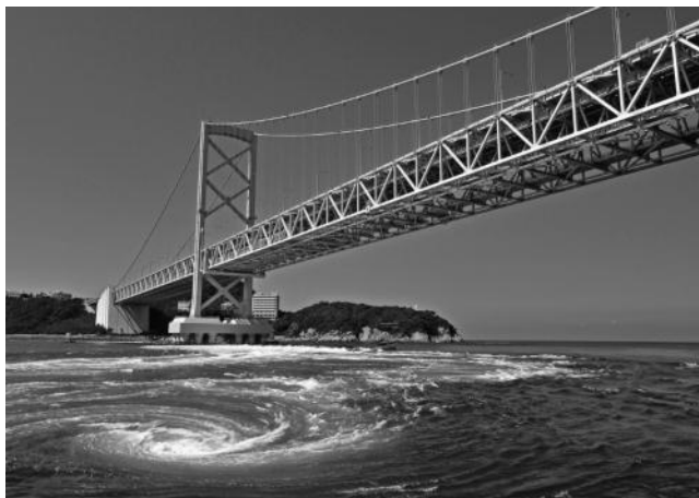
鳴門の渦潮の45m上にかかる大鳴門橋。渦潮に影響を与えないように、塔基部は多柱式の下部構造で支える。出典：鳴門の渦潮（鳴門海峡）- 徳島県観光情報サイト阿波ナビ (awanavi.jp)
