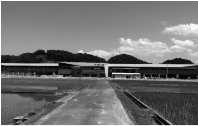
(令和4年6月1日現在の建設中の「越前たけふ駅」)
