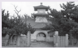
1869 設置当初の新潟運上所。今も建物が現存している。
