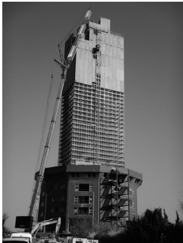
解体撤去工事の様相
