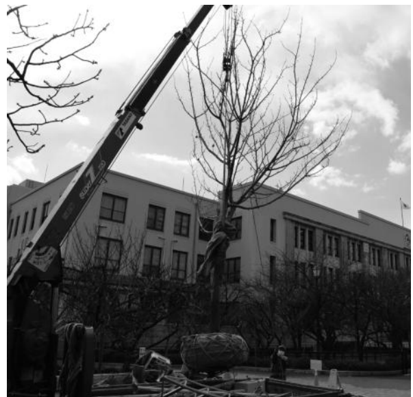
養成地より通り抜け通路への桜樹の移植
