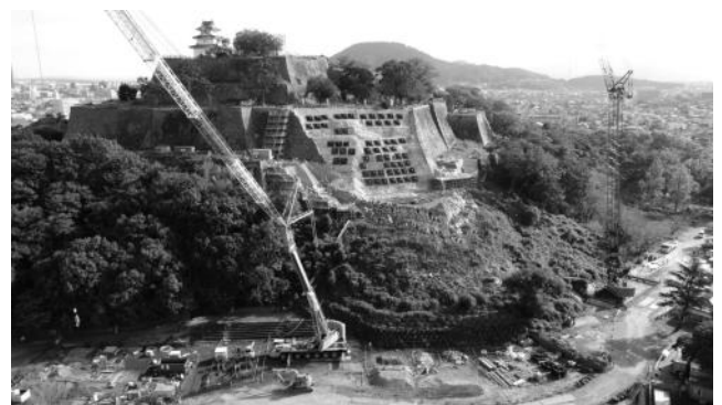
令和3年9月復旧工事の現況（提供：丸亀市）
