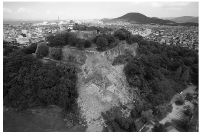
平成30年10月崩落后（提供：丸亀市）
