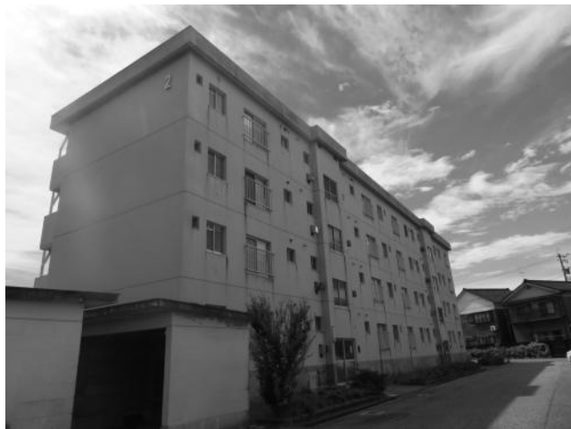
輪島宿舎2号棟
