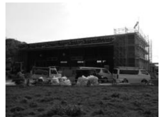
建設中のエコセンター （令和2年10月撮影）
