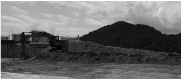
災害土砂仮置場
