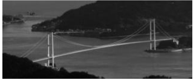
安芸灘大橋（手前）と蒲刈大橋（左奥）
