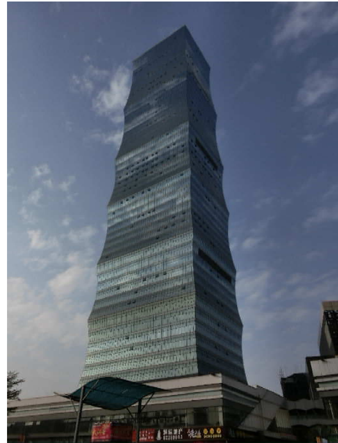
鎮にそびえる高層ビル
