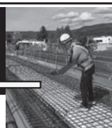
スマートフォン、タブレットをかざすだけで配筋検査における検査項目の3次元測定値を算出
