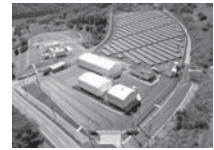
米倉山電力貯蔵技術研究サイト (出所：山梨県HP)
