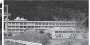
既存の中学校校舎を利活用予定
