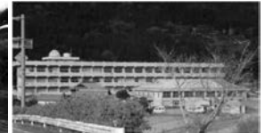
既存の中学校校舎を利活用予定
