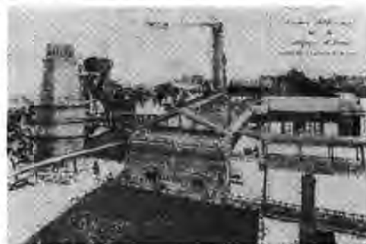
官営深川セメント工場
