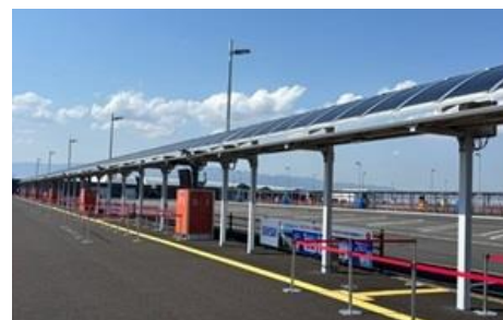
2025年日本国際博覧会のバスシェルターに設置された積水のフィルム型ペロブスカイト太陽電池
