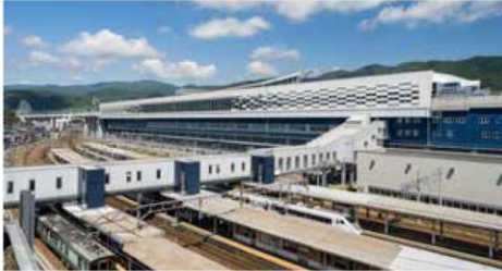
(独) 鉄道建設・運輸施設整備支援機構/整備新幹線事業/北陸新幹線/福井県敦賀市
