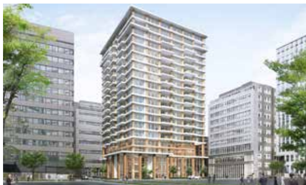
(株)日本政策投資銀行/(株)シェルターへの出資/木造建築物(完成予想図)/山形県山形市(本社所在地)
