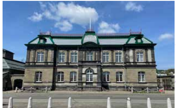
北海道小樽市/過疎対策事業【重要文化財旧日本郵船(株)小樽支店保存修理事業】/ 旧日本郵船(株)小樽支店/北海道小樽市
