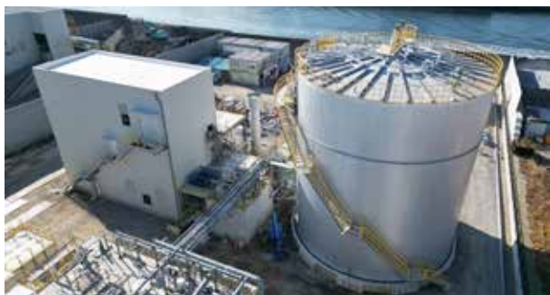
(株) 脱炭素化支援機構/株式会社コベックに対する融資(食品廃棄物を回収・発酵処理し、隣接する発電所へメタンガスを販売する事業)/メタン発酵による廃棄物処理施設/兵庫県神戸市
