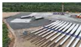
(建設中の様子)
