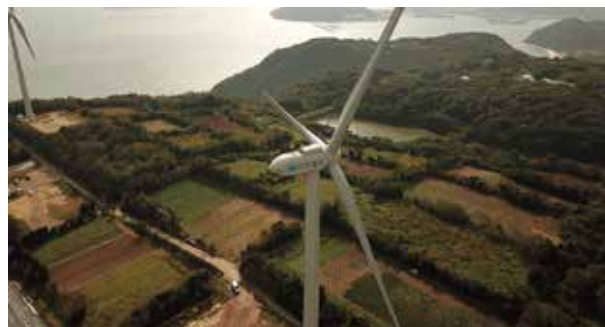
JICベンチャー・グロース・インベストメンツ(株)/自然電力(株)に対する出資/風力発電所/佐賀県唐津市
