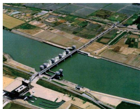
頭首工：河川から農業用水を安定的に取水する施設
