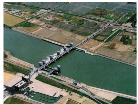
頭首工：河川から農業用水を安定的に取水する施設
