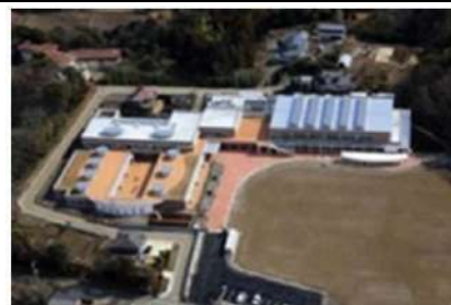
小学校の改修事業
