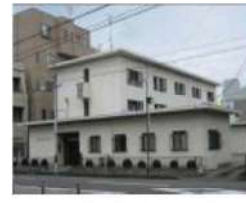
更生保護施設の外観
