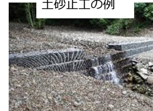
土砂止工の例
