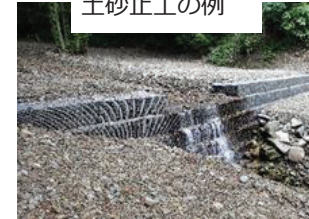
土砂止工の例
