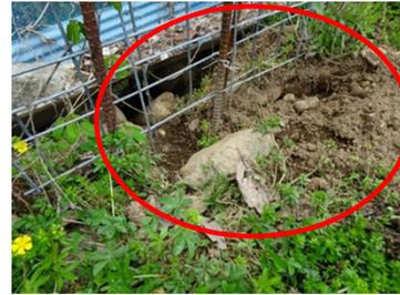
鳥獣に地面を掘られ隙間が生じている箇所
