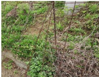
柵の接地面への固定が不十分な箇所
