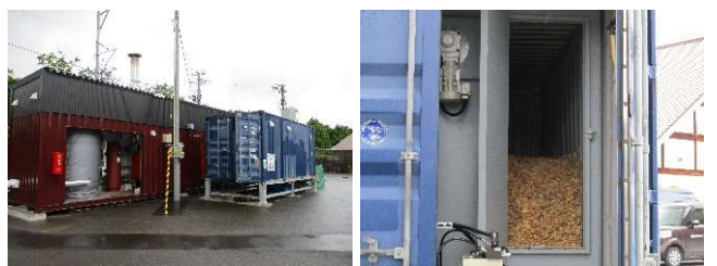
バイオマスボイラー
