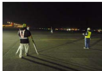
【人力による水準測量状況】 滑走路等の縦横断勾配を計測
