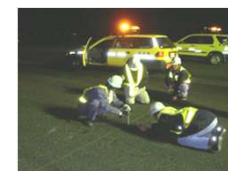
【ひび割れ計測】
