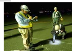
【ひび割れ記録】
