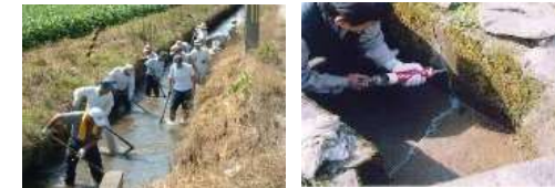
水路の泥上げ 水路のひび割れ補修
