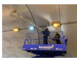
レーダーを利用したトンネル覆工の損傷把握
