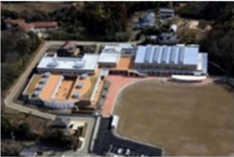
小学校の改修事業
