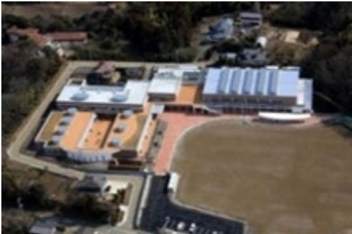
小学校の改修事業
