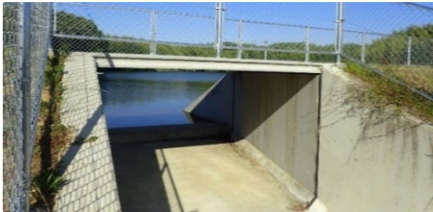
農業用排水施設の整備
