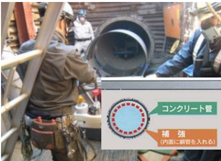
管路の耐震補強
