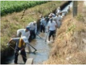
水路の泥上げ
