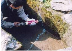
水路のひび割れ補修
