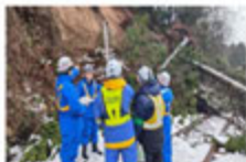
▲TEC-FORCEによる被災状況調査
