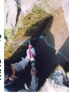
水路のひび割れ補修
